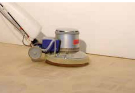
BODEN SCHLEIFEN
