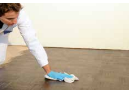
ÜBERSCHUSS ENTFERNEN
